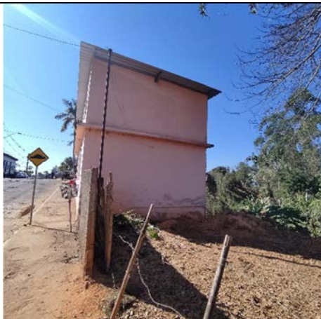
Foto 3: Vista lateral esquerda do edifício. Alex Alves Pereira, 17 jul. 2025.
