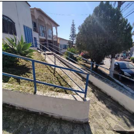
Foto 2: Em detalhe, rampa de acesso a entrada da edificação. Alex Alves Pereira, 17 jul. 2025.
