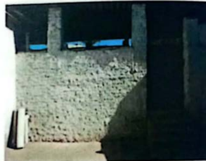
Foto 04- Vista da área externa - acesso ao salão contíguo Município de Caranaíba - MG.
