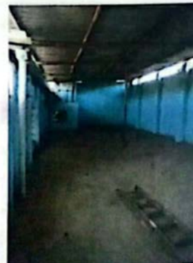
Foto 06 - Vista interna do salão contíguo Município de Caranaíba - MG.
