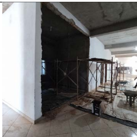
Foto 4: Obra em progressão com a demolição das paredes dos cômodos laterais. Alex Alves Pereira, 17 jul. 2025
