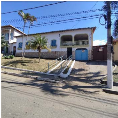
Foto 1: Vista da Fachada frontal da Casa Paroquial. Alex Alves Pereira, 17 jul. 2025.
