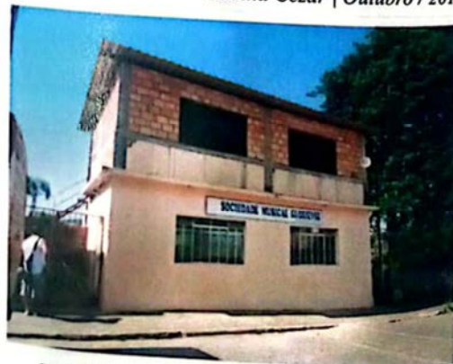
Foto 2. Vista da fachada frontal da edificação Município de Caranaíba/MG Marina Cezar, outubro/ 2016.
