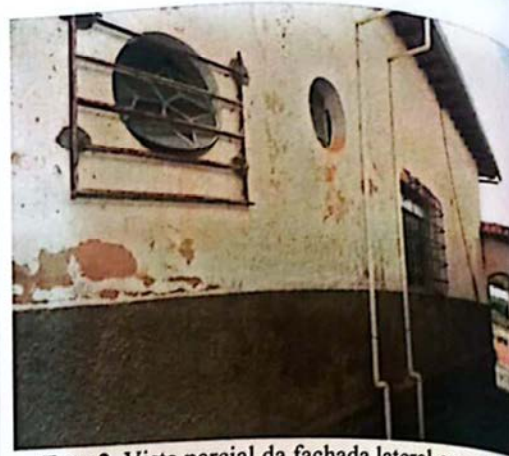
Foto 2. Vista parcial da fachada lateral esquerda (sudoeste) da edificação.
