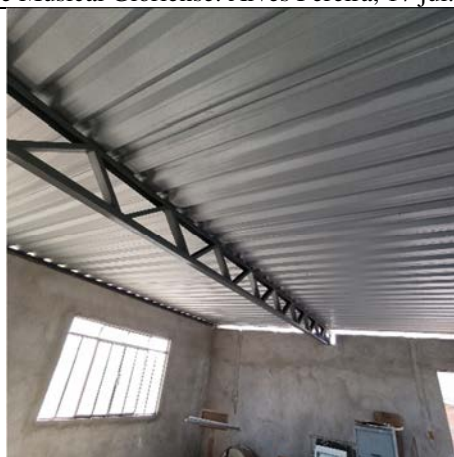
Foto 6: Registro da cobertura instalada no segundo pavimento da edificação. Alex Alves Pereira, 17 jul. 2025.
