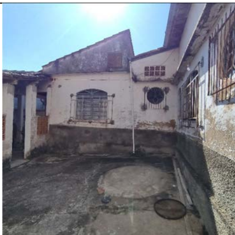
Foto 3: Vista parcial da fachada lateral esquerda com manchas de umidade e descascamentos na camada pictórica. Alex Alves Pereira, 17 jul. 2025.
