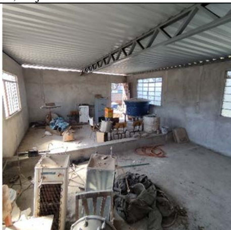
Foto 7: Vista geral do segundo pavimento, ainda inacabado. Alex Alves Pereira, 17 jul. 2025.
