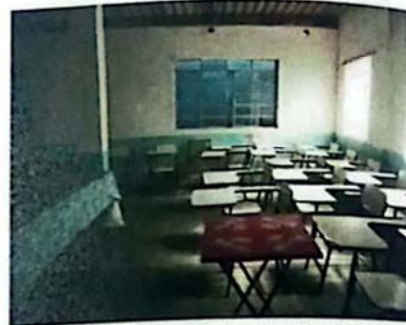
Foto 02- Vista interior da edificação Município de Caranaíba - MG.
