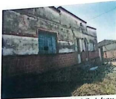
Foto 01- Vista da fachada frontal do Salão de festas e eventos da Igreja Nossa Senhora da Glória Município de Caranaíba - MG.
