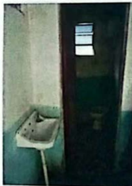
Foto 05- Vista dos sanitários Município de Caranaíba - MG.
