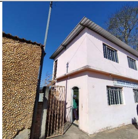
Foto 2: Vista em perspectiva da fachada lateral direita da edificação, local de acesso ao segundo pavimento. Alex Alves Pereira, 17 jul. 2025.
