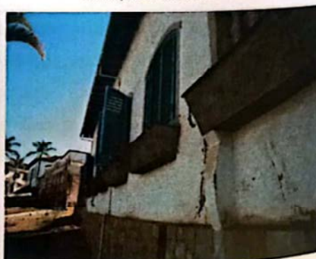
Foto 06 – Fachada frontal com janelas e jardineiras Município de Caranaíba – MG
