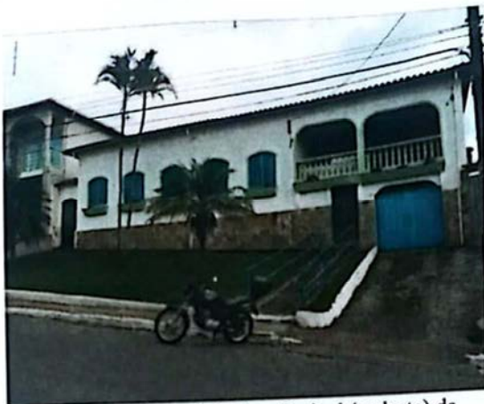
Foto 1. Vista da fachada principal (sudeste) da edificação.
