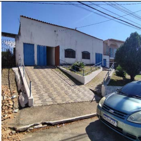
Foto 1: Vista da fachada frontal do Salão de Festas e Eventos da Igreja da Nossa Senhora da Glória. Alex Alves Pereira, 17 jul. 2025.
